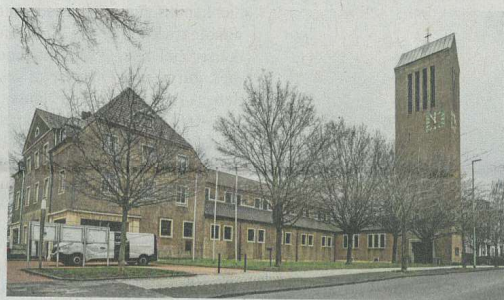
In der Kirche haben die Rückbauarbeiten begonnen. Ihre Glocken werden stillgelegt, die Uhr bleibt auf fünf vor zwölf stehen.
